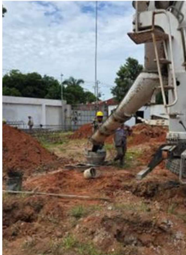
Vista de la obra Z24 – Cargamento de Pilotes
